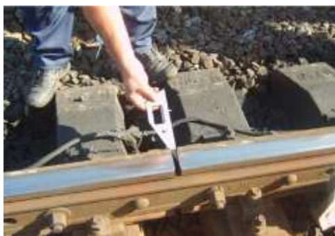
Рис. 7. Стык железнодорожного рельса
